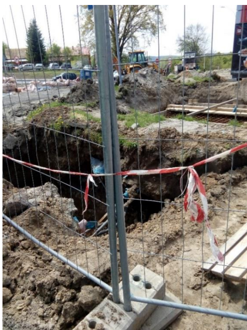
Głęboki wykop o pionowych i niemocnionych ścianach
