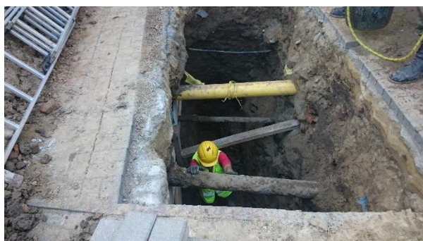
Brak obarierowania ścian wykopu
