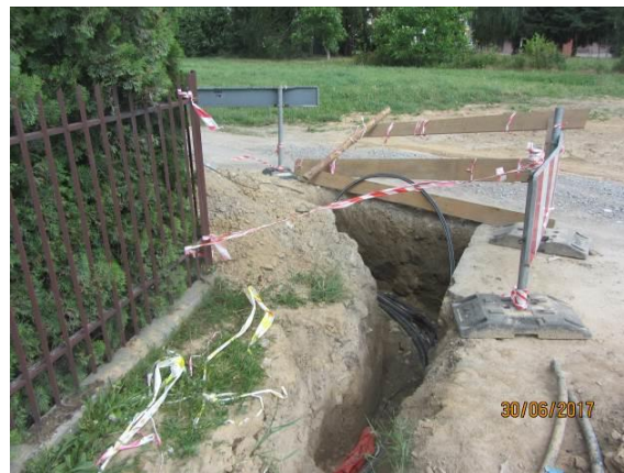
Nieprawidłowe ogrodzenie i oznakowanie miejsc niebezpiecznych (wykopów)
