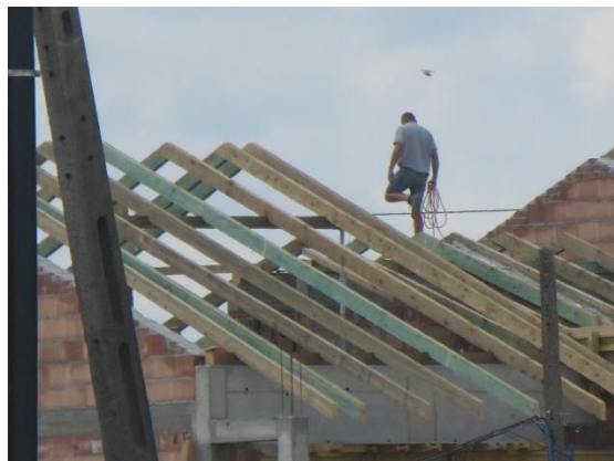
Osoby wykonujące prace na dachu budynku - brak zabezpieczeń przed możliwością upadku z wysokości, niestosowanie hełmów ochronnych
