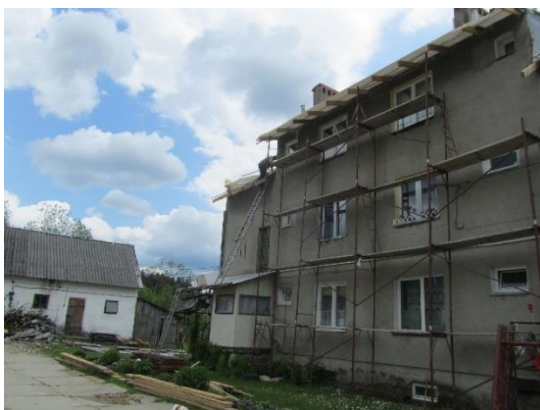
Jedyna droga komunikacyjna (dwie drabiny) na dach budynku, na którym prowadzona była wymiana pokrycia. Pierwsza drabina ustawiona na poziomie terenu i prowadząca na daszek wiatrołapu, prowadząca na dach budynku
