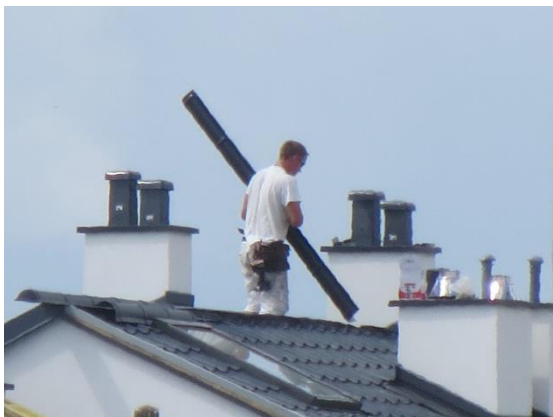
Osoby wykonujące prace na dachu budynku - brak zabezpieczeń przed możliwością upadku z wysokości, niestosowanie hełmów ochronnych
