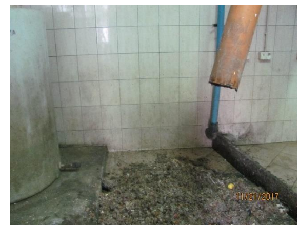
Brak rozwiązań organizacyjno-technicznych, zapobiegających zanieczyszczeniu powierzchni podłóg i ścian oraz ręcznemu transportowi piaski ze skratkami
