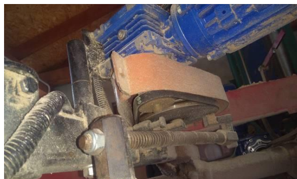
Brak skutecznych osłon bądź urządzeń ochronnych ograniczających bezpośredni dostęp do przekładni pasowej napędu odpowiedzialnego za zmianę położenia korowarki
