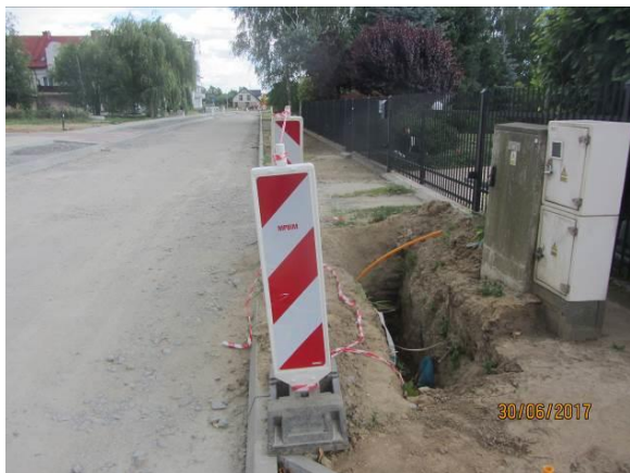
Nieprawidłowe ogrodzenie i oznakowanie miejsc niebezpiecznych (wykopów)
