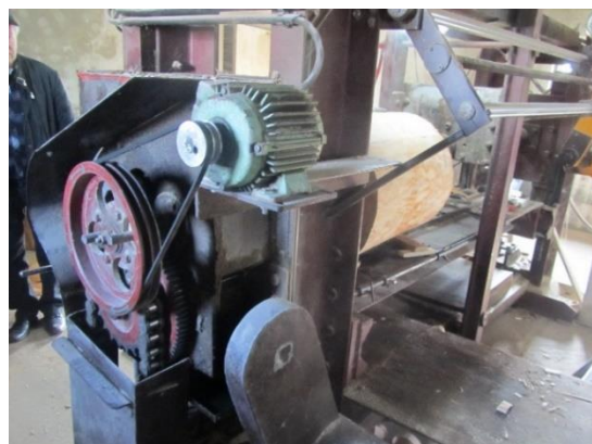
Elementy napędowe łuszczarki do forniru. Brak osłony przekładni napędowych usytuowanych w zasięgu kończyn górnych oraz zlokalizowanych bezpośrednio przy przejściu komunikacyjnym
