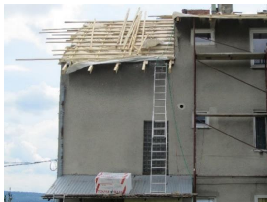
Jedyna droga komunikacyjna (dwie drabiny) na dach budynku, na którym prowadzona była wymiana pokrycia. Pierwsza drabina ustawiona na poziomie terenu i prowadząca na daszek wiatrołapu, prowadząca na dach budynku
