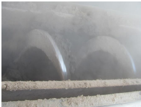
Ekspluatowanie przenośnika ślimakowego bez niezbędnych osłon stref niebezpiecznych
