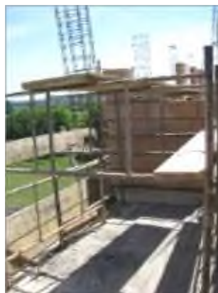
Wykonywanie prac murarskich na rusztowaniach „warszawskich” nie wyposażonych w pełne pomosty robocze, poręcze ochronne oraz pionowe komunikacyjne
