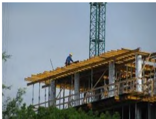
Wykonywanie prac na wysokości bez zabezpieczenia osób wykonujących pracę przed możliwością upadku z wysokości
