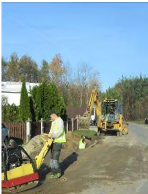
Dopuszczenie pracownika do pracy w zasięgu działania naczynia roboczego koparki, dopuszczanie pracowników do pracy bez hełmów ochronnych głowy, ochronników słuchu i rękawic ochronnych
