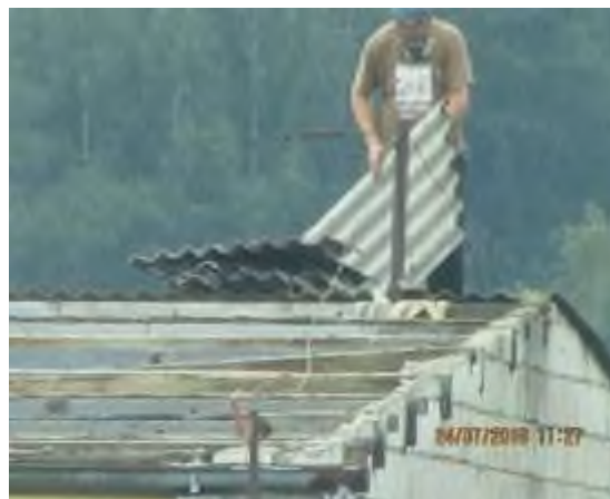
Zleceniobiorca w odzieży własnej, nieposiadający środków chroniących drogi oddechowe przed pyłami azbestu oraz środków ochrony indywidualnej chroniących przed upadkiem z wysokości
