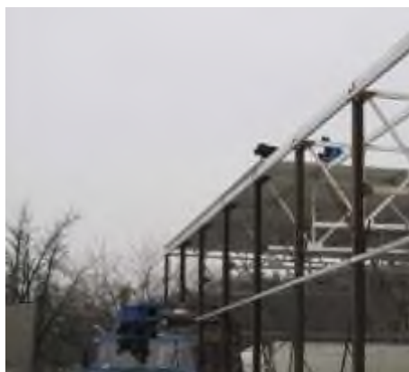
Wykonywanie prac na wysokości bez zabezpieczenia osób wykonujących pracę przed możliwością upadku z wysokości
