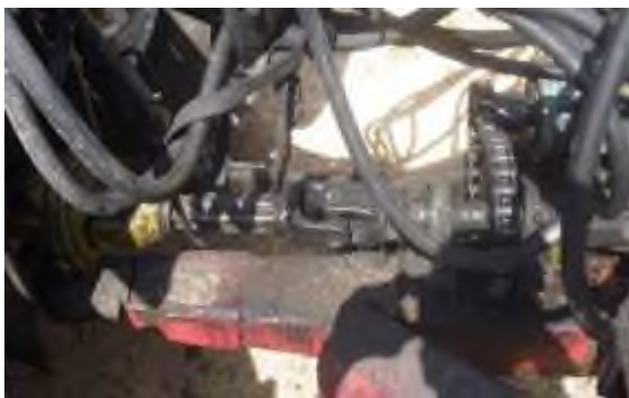
Brak osłony wałka odbioru mocy oraz brak osłony przekładni zębatej
