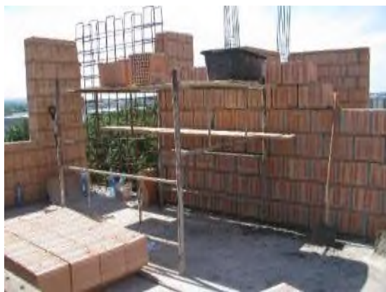
Wykonywanie prac murarskich na rusztowaniach „warszawskich” nie wyposażonych w pełne pomosty robocze, poręcze ochronne oraz pionowe komunikacyjne
