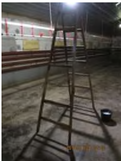
Niesprawną technicznie drabiną drewnianą (wyłamany szczebel, uzupełniony metalowym prętem oraz liczne uszkodzenia struktury drewna)
